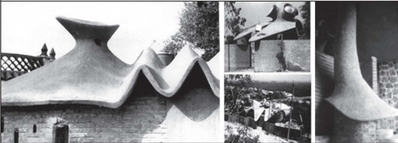
Figura 1. Izquierda: primera cubierta de hormigón armado sobre metal desplegado sin encofrado 1958. Carlos González Lobo, en colaboración con Rodolfo Gómez Arias, Darío de Hoyos, R. Pacheco y A. Guerrero. Derecha: Casa particular para Jorge González Camarena. Ciudad de México, 1976.
